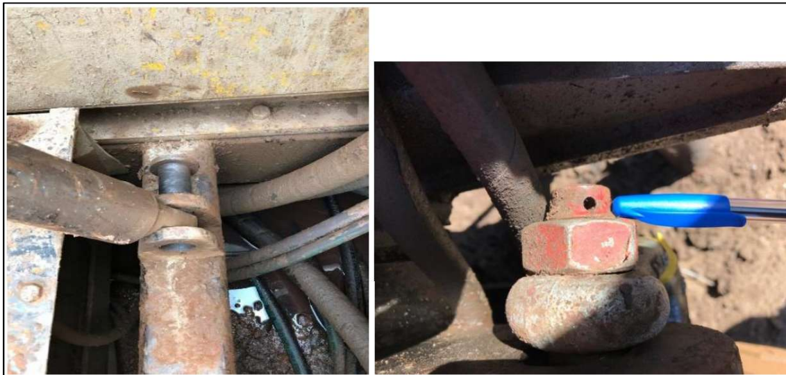
Exemplo de falta de contra pinos
